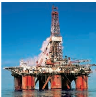
Для выполнения антикоррозийных работ на платформах требуется выносливая техника.
