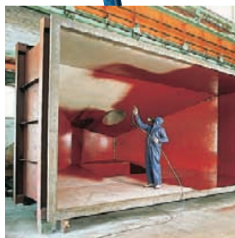
Высокая производительность плюс эргономичность ценятся при работе с большими металлоконструкциями.
